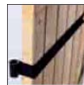
Volet Gardois, penture inversée et emboîture
